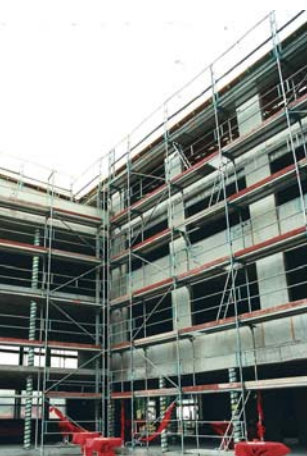
2009: Richtfest für Firmensitz Kurhessenstraße
